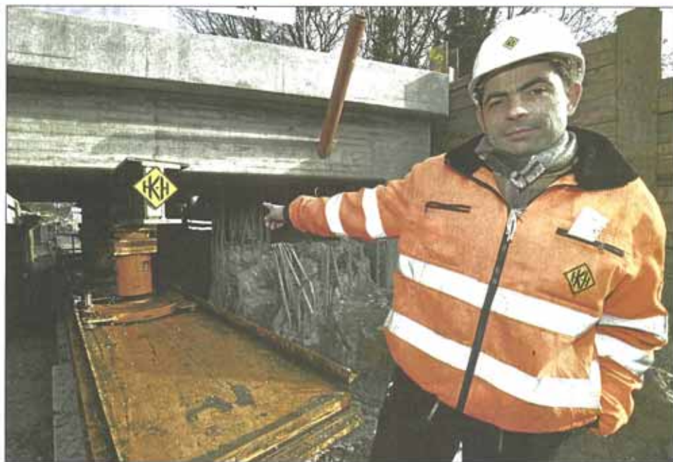
Mit mächtigen Vershubpressen, die Polier Paulo Teixeira hier zeigt, schoben die Bauarbeiter am Samstag die neue Eisenbahnbrücke für die WLE auf einer 20 Meter langen Bahn in ihre Position. ■ Fotos: Salmen
